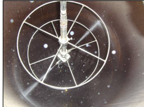
煙突内部2Dノズルによる自動洗浄
