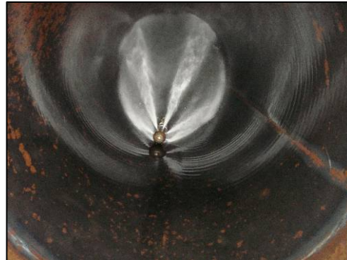
ダクト内部自走式ノズルによる洗浄
