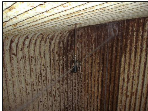
ボイラ上部3Dノズルによる自動洗浄
